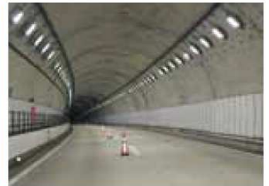
改良後 (LED照明灯具)
