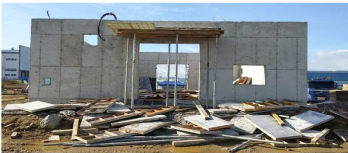
危険物保管倉庫
