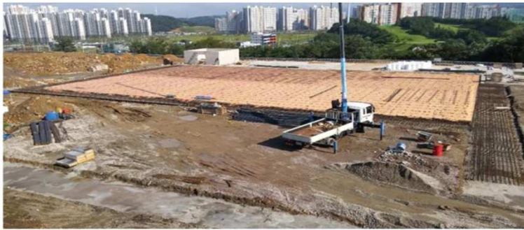
工事が進む韓国第2工場
