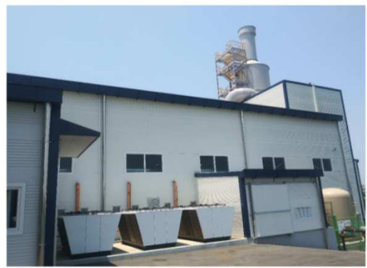
吸塵装置とクーリングタワー ここで空気清浄化しています
