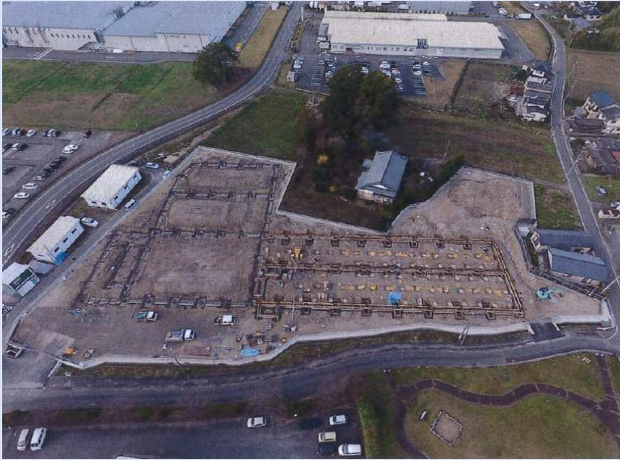
ルミナス佐賀の建設は順調です。12月中に基礎工事を終え、1月からは鉄骨とパネルの組立に入ります。既存の工場も組立の訓練を始めました。これから来春の竣工に向けて、全員で頑張っていく正念場を迎えます。左の写真はドローンで撮影した佐賀工場の建設風景です
