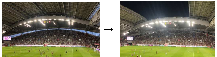
試合前半まで降っていた雨が止み、後半から屋根が開きました。外の涼しい風が入り、自然冷房でエコ！
