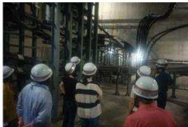
▲東京電力(株) 新豊洲変電所
